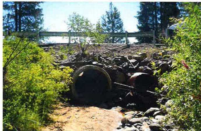
N.F. Teanaway Rd existing culverts
